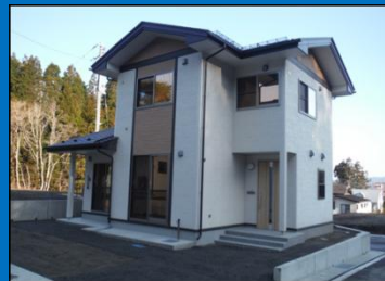
久慈市 元木沢団地 木造2階 戸建て 3戸 H26年3月竣工
