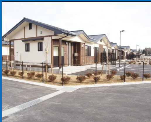
野田村 門前小路第2団地 (野田②団地) 木造平屋 長屋建て18戸 H26年1月竣工
