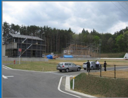
野田村 防集事業 米田・南浜地区 H25年11月完成 (民間区画18、災害公営区画6)
