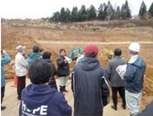
・ A-B 地区境界部の掘削状況
