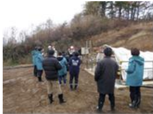
・ A 地区に新たに設置した大型集水井戸
