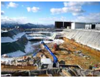
N地区汚染土壌掘削終了
