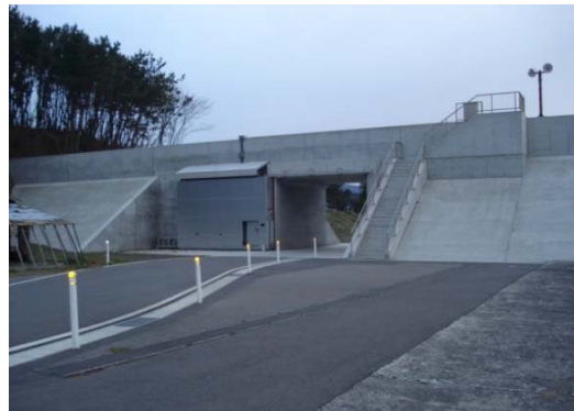
陸閘 道路として開放している部分であり、津波時には扉を閉める
