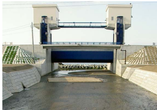
水門 門を閉めることで津波が川に沿って浸入するのを防ぐ
