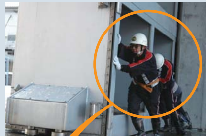
陸閘の閉鎖状況
