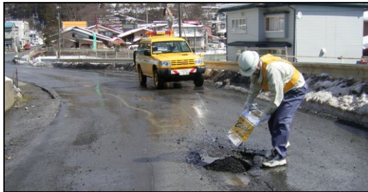
パトロールによる穴埋め作業
