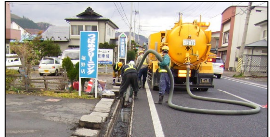
側溝清掃作業
