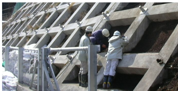
県営建設工事完成検査状況
