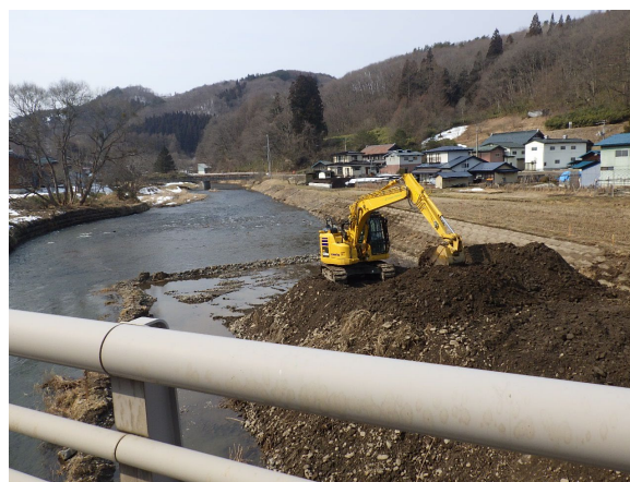
河道断面維持のための掘削作業
