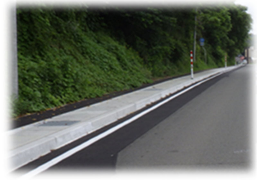
歩道の設置（例）
