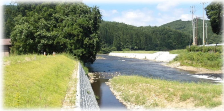
河川の改修（例）
