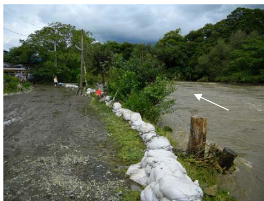
馬淵川 いわねばし 岩根橋下流左岸(関屋地区) せきや
