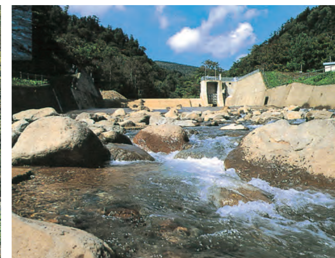
北ノ又川第二取水堰堤
