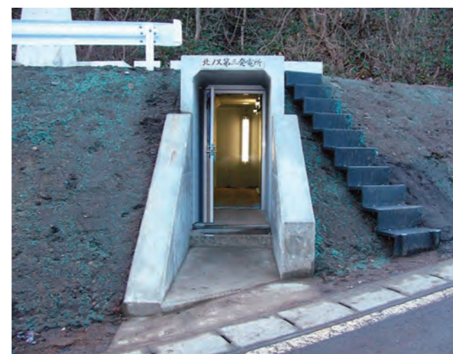
北ノ又第三発電所（入口）
