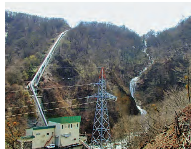
北ノ又発電所
