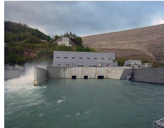
胆沢第三発電所
