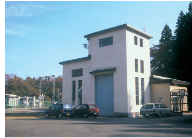
胆沢第二発電所
