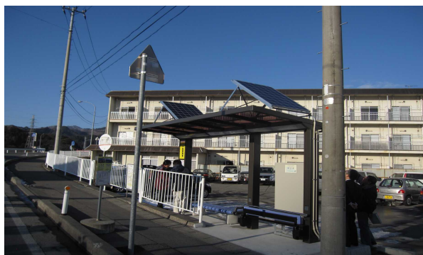
クリーンエネルギー導入支援事業（大穂町 県立病院前バス待合室ソーラー照明）
