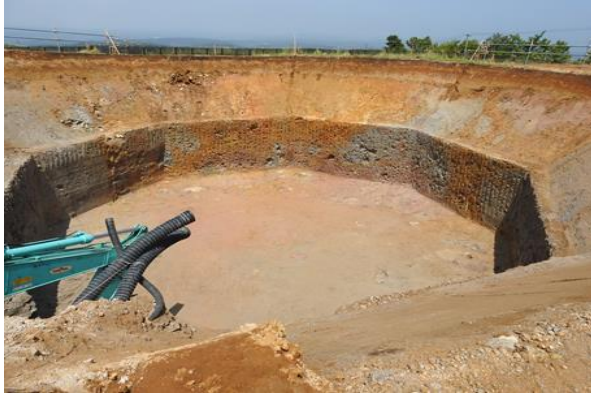
風車の基礎となる部分を掘削します。
