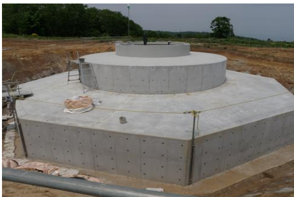
基礎コンクリートを打設します。
