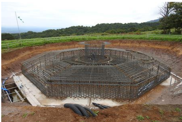
基礎部分の強度を高めるため、鉄筋を組みます。
