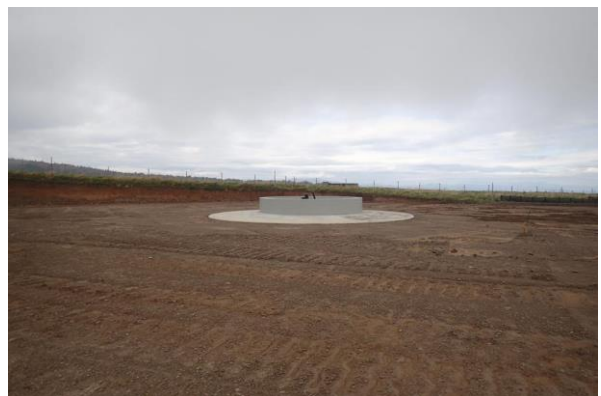
埋め戻して基礎が完成です。
