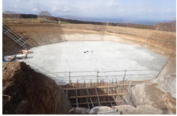
固い地盤の代わりとなるコンクリートを打設します。
