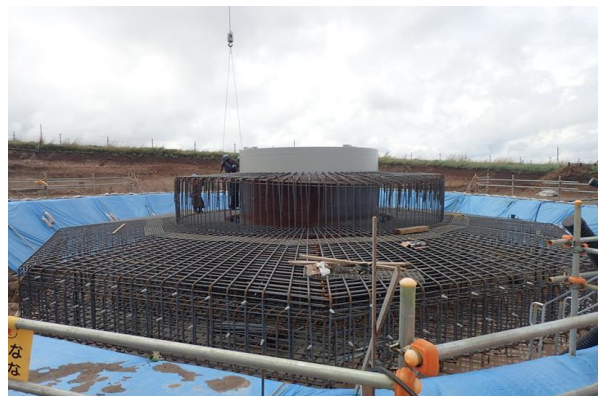
組んだ鉄筋に風車にあたる部材を組み合わせます。
