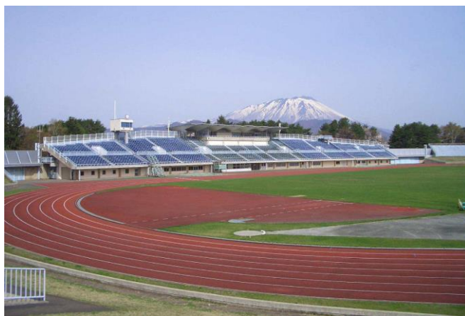
<岩手県営運動公園陸上競技場>
