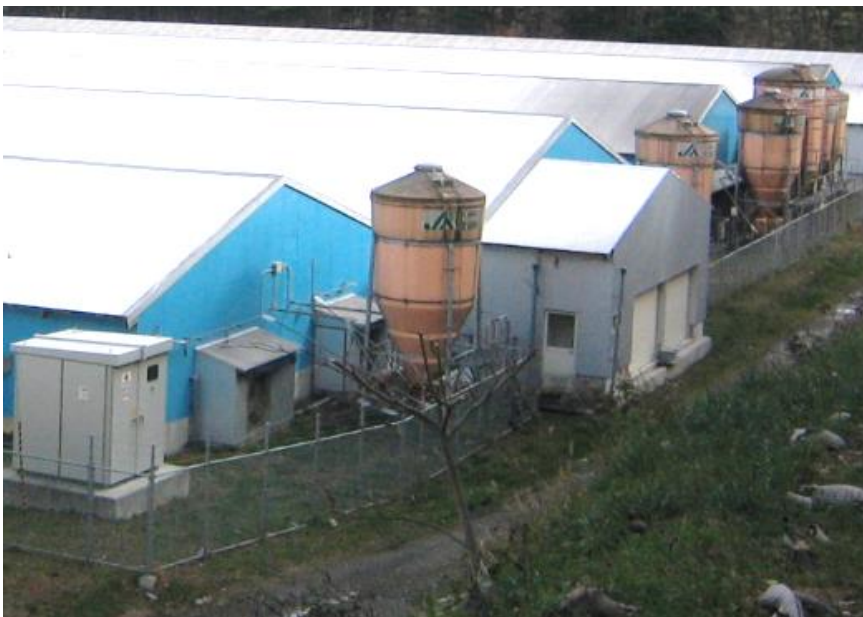
「衛生管理区域全体へ金網の設置」
