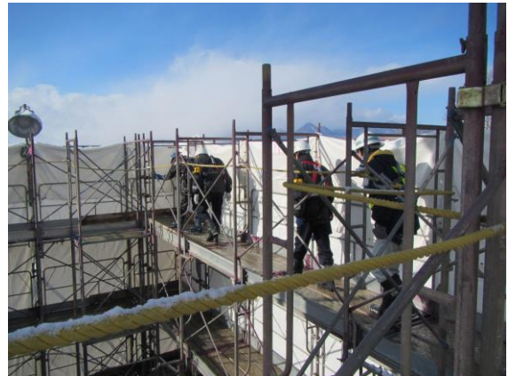
足場点検状況（フルハーネス型安全帯着用）
