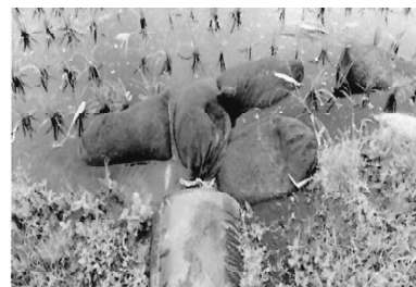
図 3 CC 炭化物投入状況
