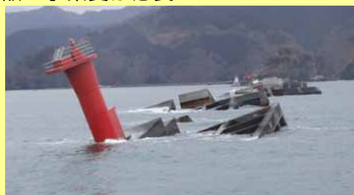
倒壊した釜石港湾口防波堤(釜石市)
