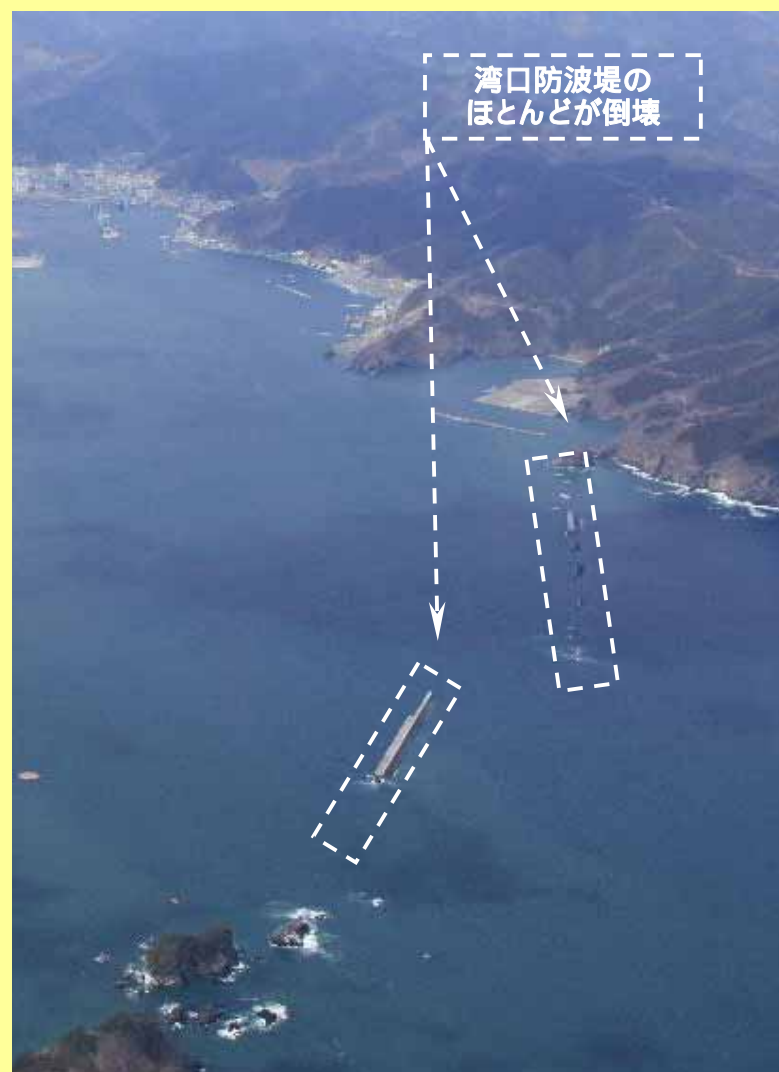
倒壊した釜石港湾口防波堤(釜石市)
