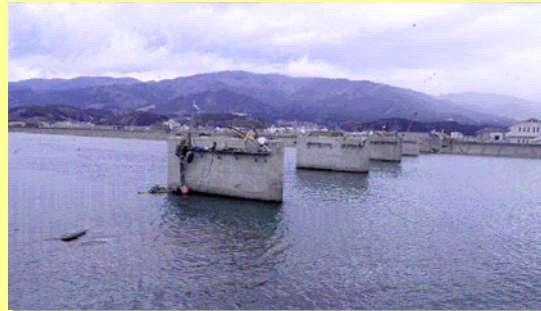
落橋した国道45号気仙大橋(陸前高田市)
