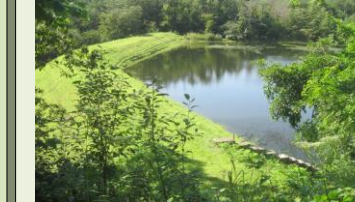
【対策が必要なため池】
