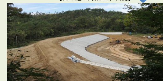
【ため池の対策工事状況】
