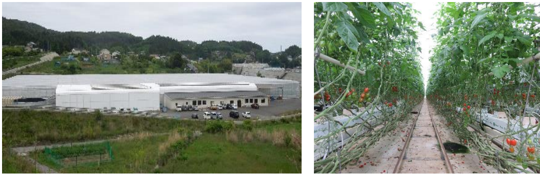
写真1 高度環境制御技術を導入した大規模施設
