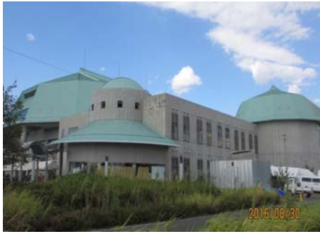
避難所となった益城町総合体育館
