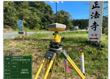
GNSS固定局設置
