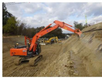
【3DMCバックホーによる切土法面整形】
