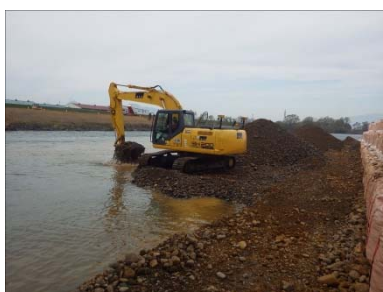
河道掘削状況
