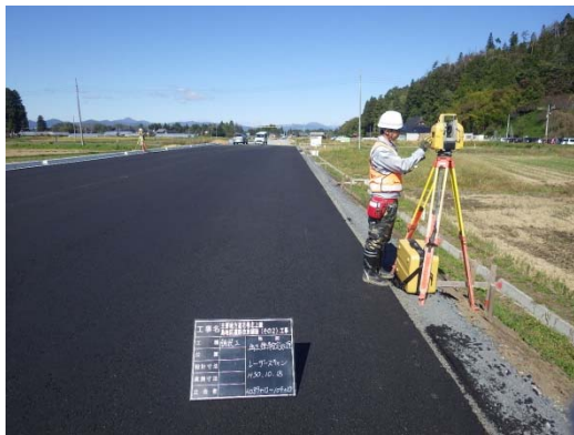
TLSによる出来形測量
