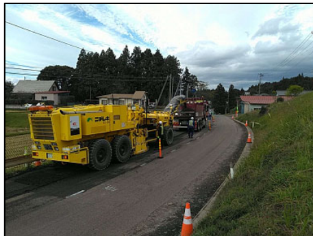
3DMCGNSS切削システムによる路面切削
