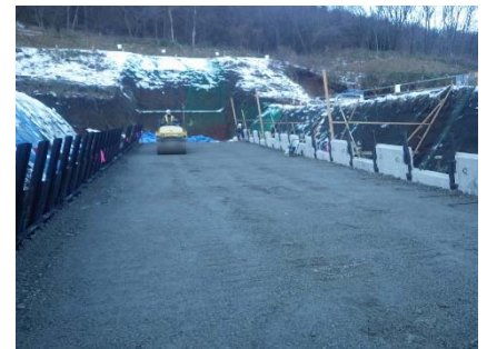
締固め後の施工基面
