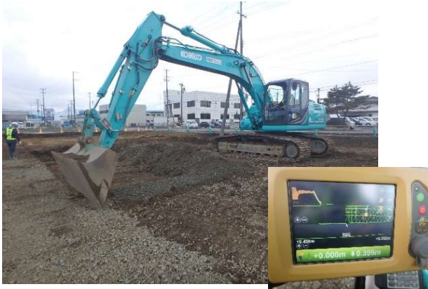
MGバックホウによる掘削
