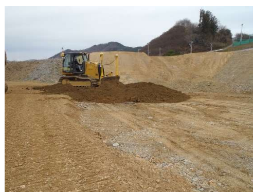
ICTブルドーザーによる整地
