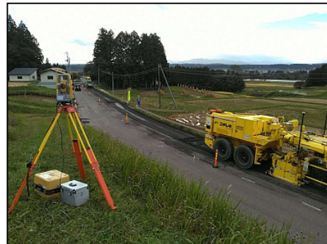
自動追尾TSによる施工精度確認
