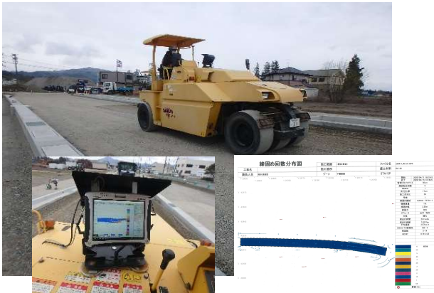
MCタイヤローラによる転圧管理
