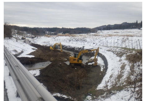
3DMCバックホウによる掘削
