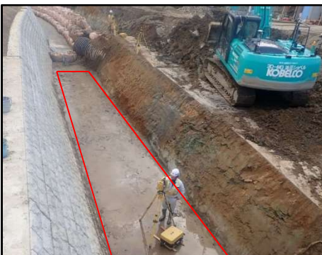
TLSによる3D出来形測量
