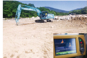
3DMGバックホウによる 河道掘削
