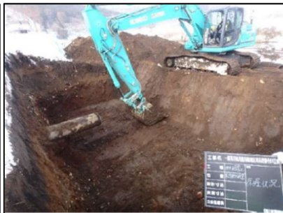
ICT建機による河川土工
