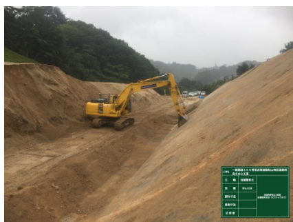
ICTバックホウによる法面整形
