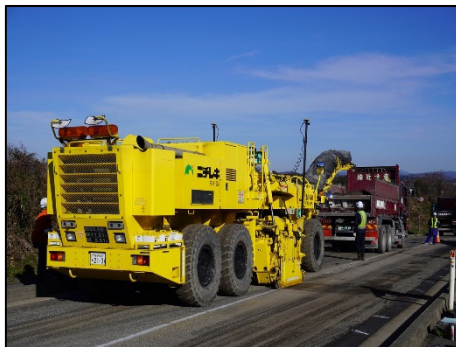
3DMCGNSS切削システムによる路面切削
