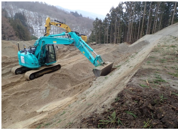
↑ 3DMCBHによる施工
