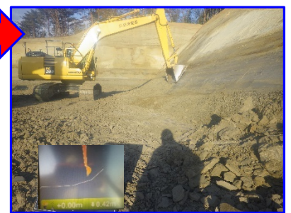
3DMGバックホウによる掘削・法面整形
