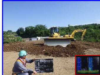
【3DMCグレーダーによる敷均し】
