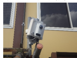
定点カメラ2台設置
