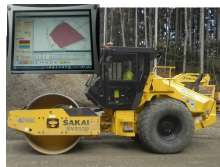
GNSS方式による締固め管理
