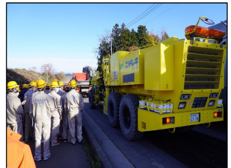
ICT施工見学会実施
