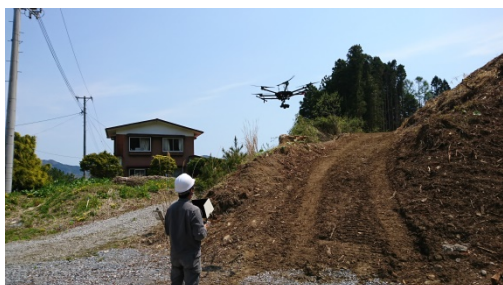
UAVIによる施工前の 空中写真測量
