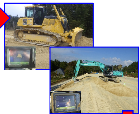
ICT建機による盛土工
