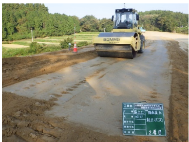
GNNSローラー締固め管理
