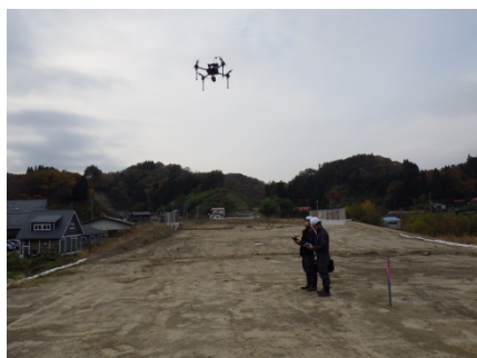
UAVによる施工前の 空中写真測量
