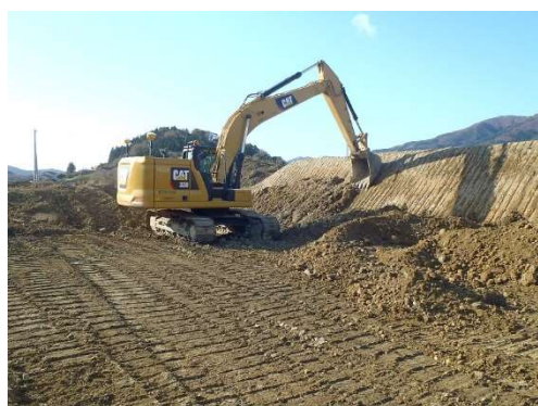
ICTバックホウによる掘削
