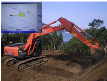
3DMGバックホウによる法面整形
