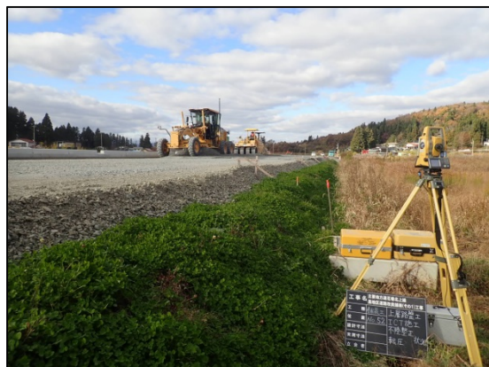
3DMCグレーダによる路盤工
