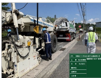
ICT施工(路面切削工)
