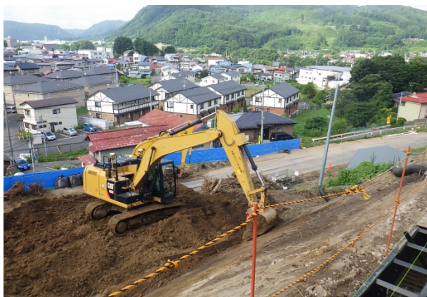
↑ 3DMCBHによる掘削 ↓ 管理画面
