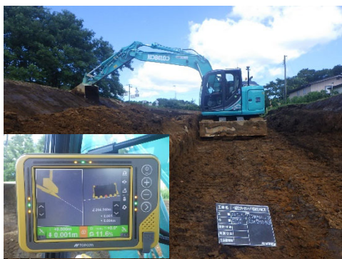
3DMGバックホウによる法面整形
