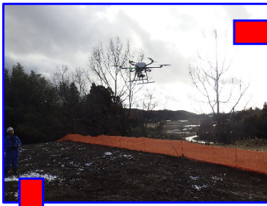
UAVIによる起工測量
