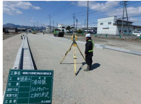
TLSによる出来形管理
