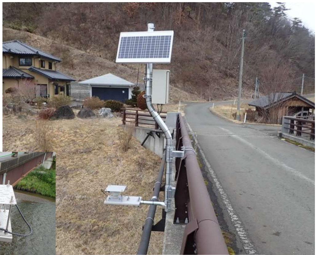
設置状況（宮守川上関谷橋（遠野市））
