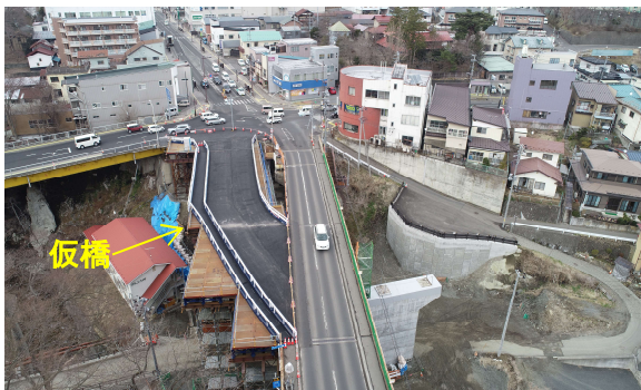
仮橋供用開始前（H31.3月）に撮影
