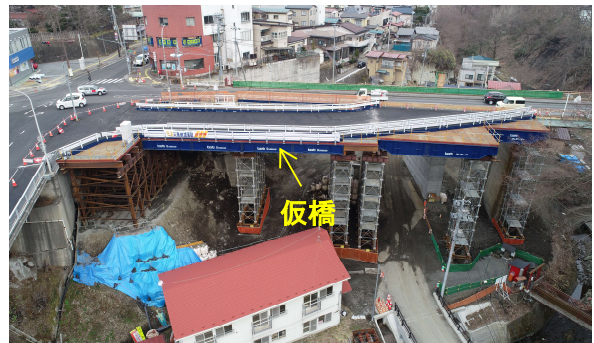
仮橋供用開始前（H31.3月）に撮影
