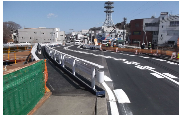
仮橋供用開始日（H31.4.16）に撮影
