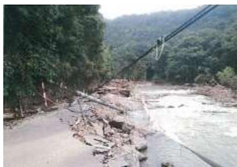
写真：平成 28 年台風第 10 号による道路被害の状況(岩泉町)
