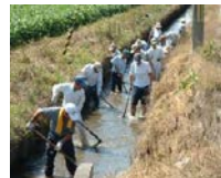
水路の泥上げ
