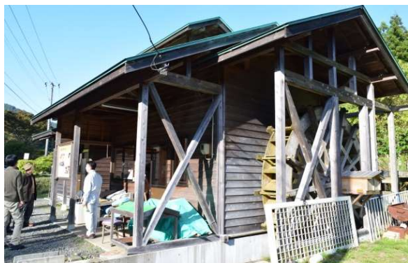
再建した水車小屋
