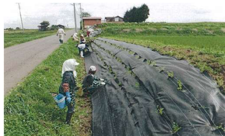
法面への植栽作業
