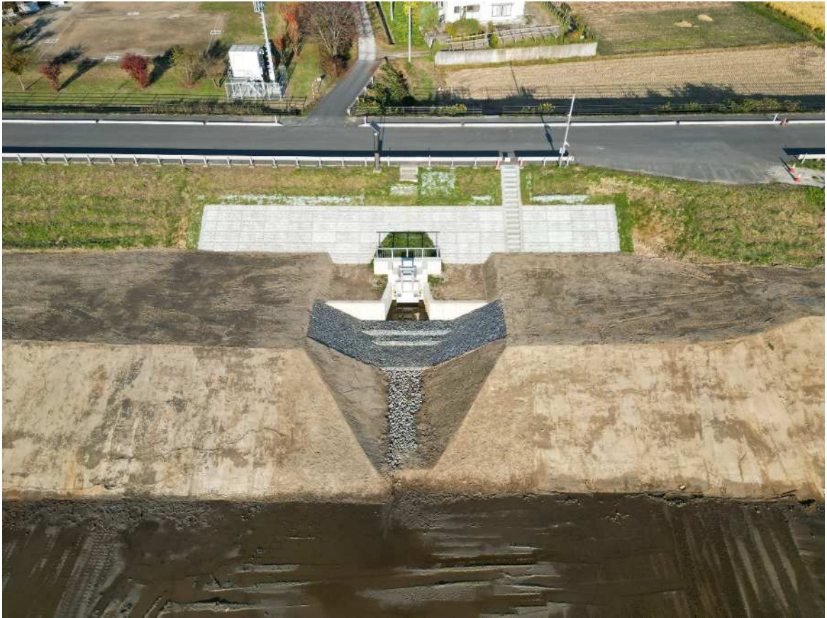
治水施設整備事業 一級河川砂鉄川筋松川地区磐井沢樋門改修工事（令和4年度完成）
