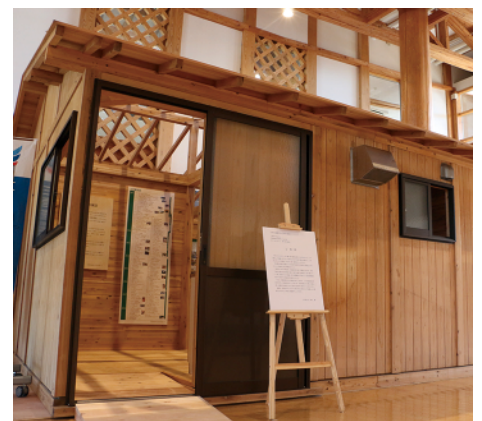
展示されている木造仮設住宅（写真提供：住田町）
