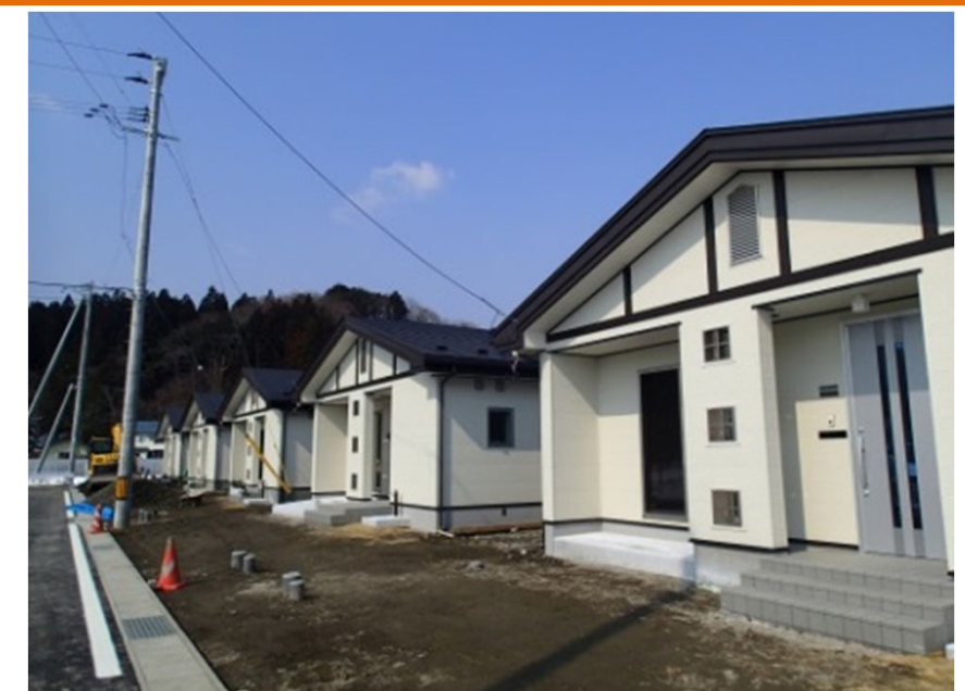
災害公営住宅 久慈湊・大崎地区
