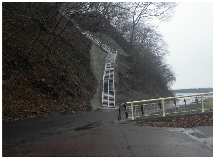
堀内地区避難路(漁業集落防災機能強化事業)
