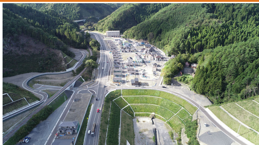
罎石地区(防災集団移転促進事業、漁業集落防災機能強化事業)
