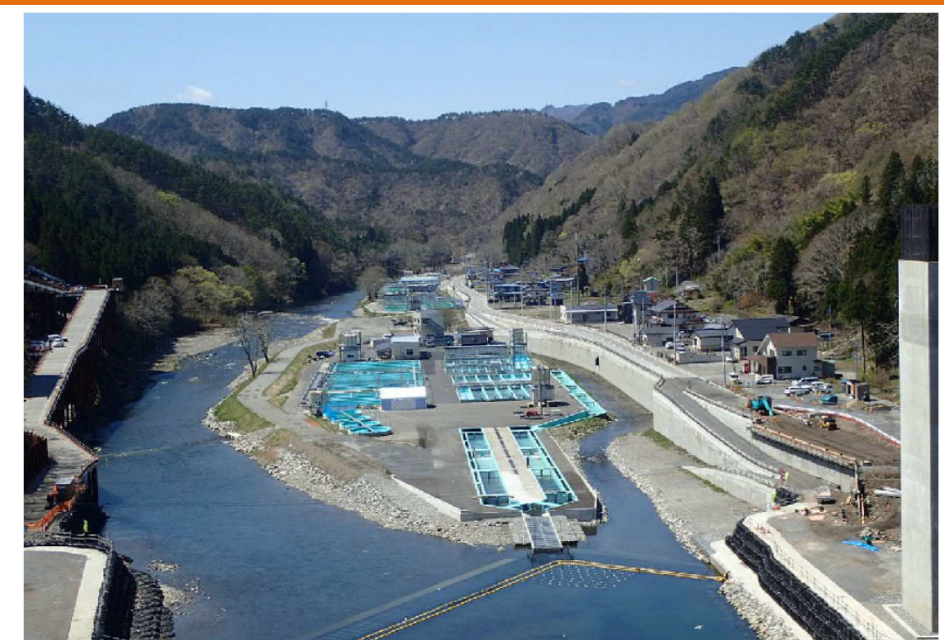
漁業集落防災機能強化事業(下安家地区(嵩上げ))
