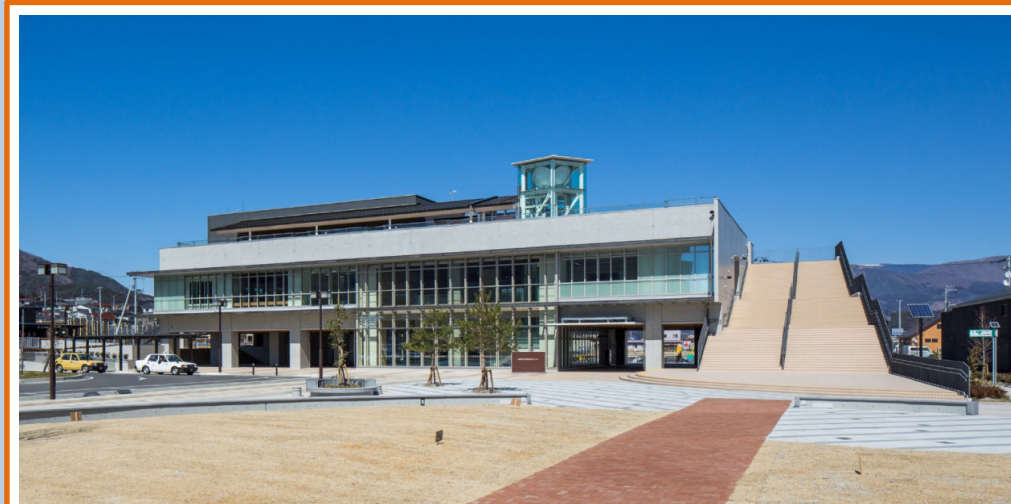
防災観光交流センター(津波復興拠点整備事業)
