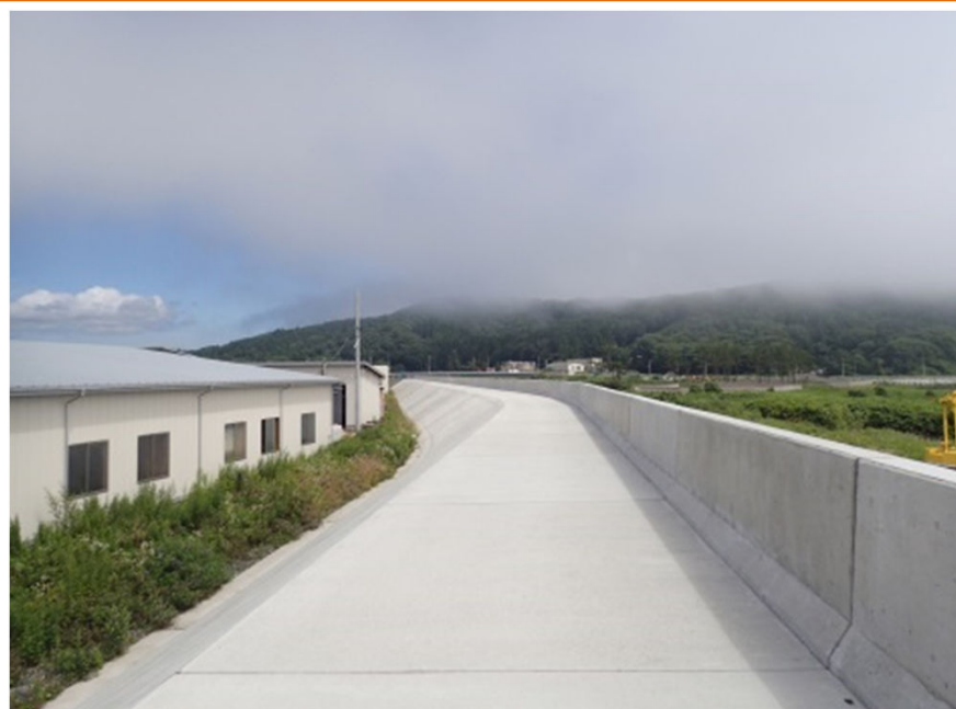
漁港海岸 久慈湊漁港海岸防潮堤
