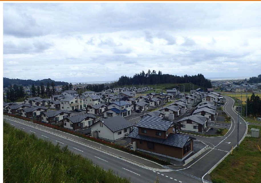
防災集団移転促進事業(城内地区)
