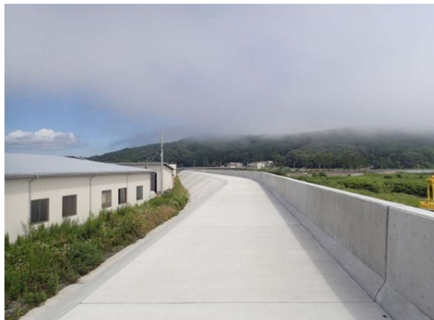
漁港海岸 久慈湊漁港海岸防潮堤
