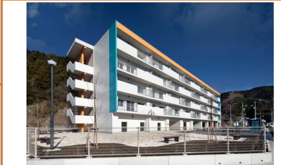
東部地区(浜町)(災害公営住宅)
