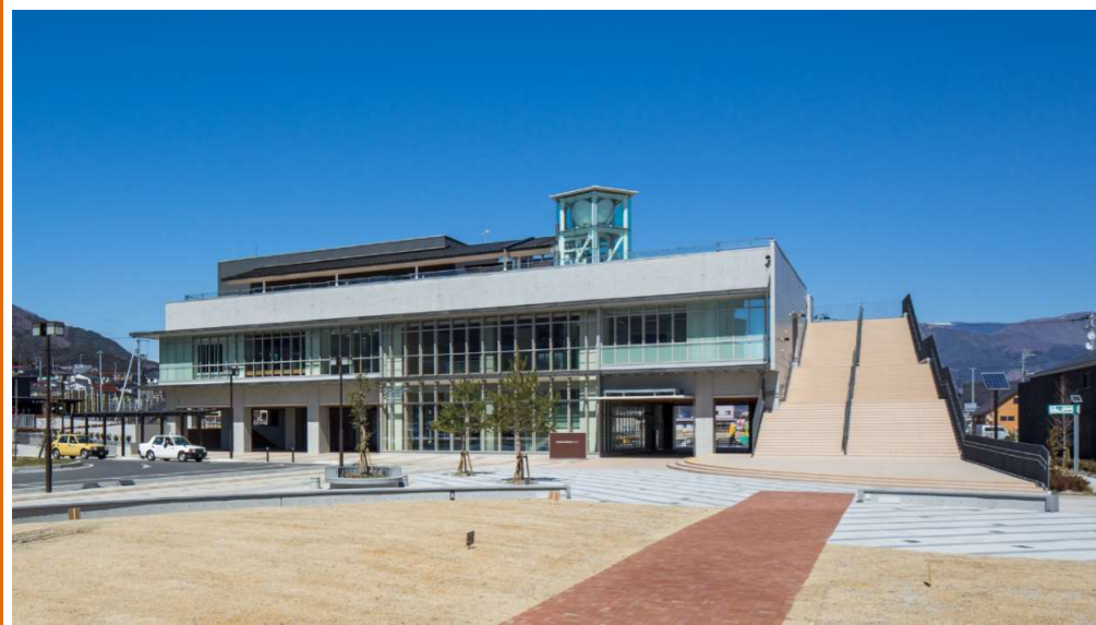
防災観光交流センター(津波復興拠点整備事業)
