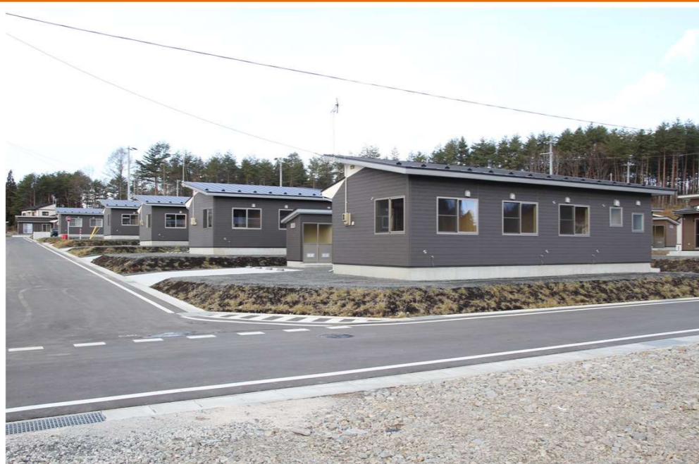
拓洋台災害公営住宅
