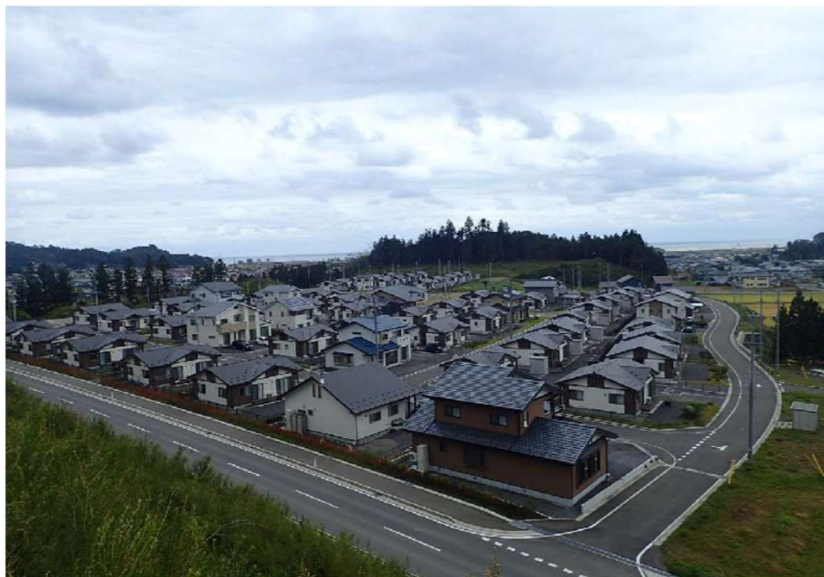
防災集団移転促進事業(城内地区)
