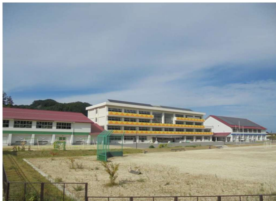
小本小学校・小本中学校(小本小学校及び小本中学校移転復旧事業)
