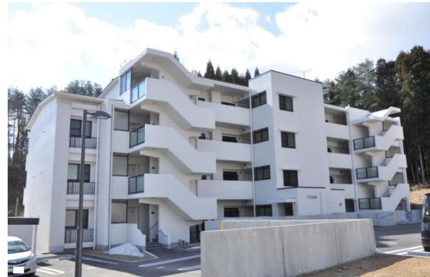
山口災害公営住宅(災害公営住宅整備事業)
