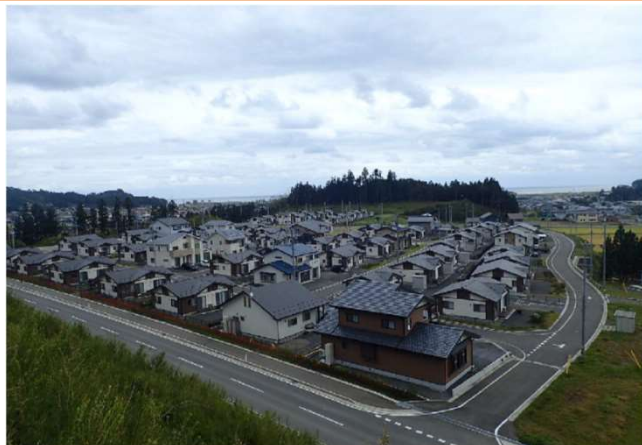
防災集団移転促進事業(城内地区)
