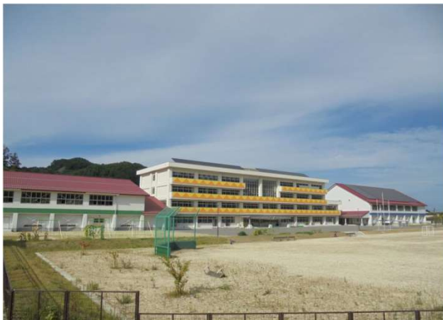
小本小学校・小本中学校(小本小学校及び小本中学校移転復旧事業)
