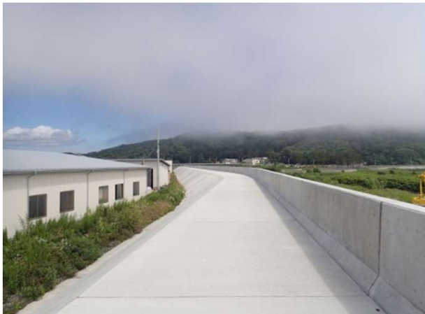
漁港海岸 久慈湊漁港海岸防潮堤
