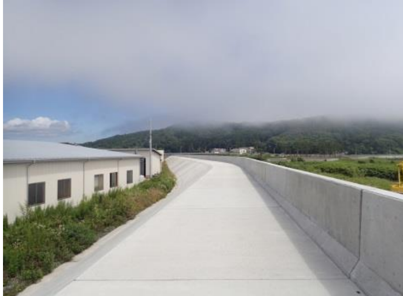
漁港海岸 久慈湊漁港海岸防潮堤
