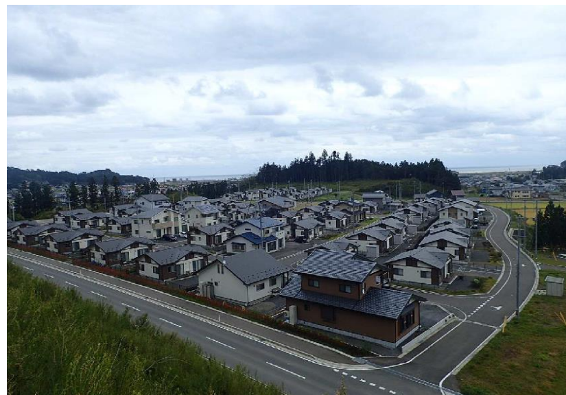
防災集団移転促進事業(城内地区)
