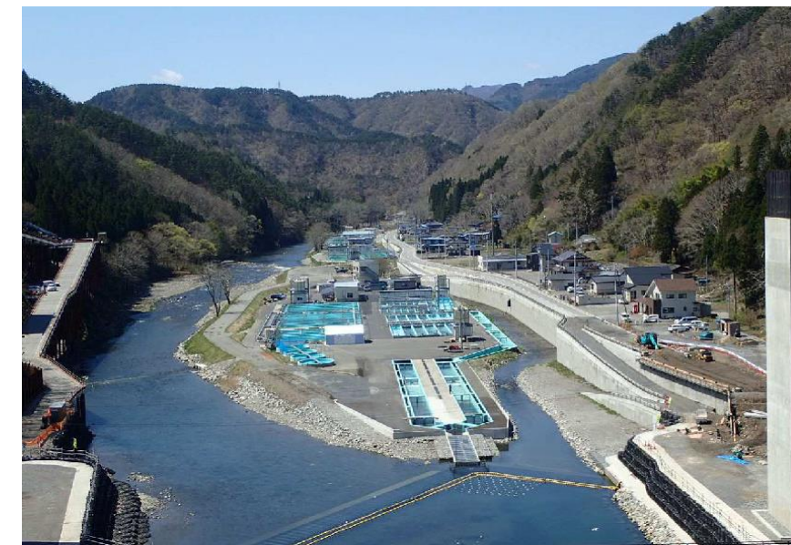
漁業集落防災機能強化事業(下安家地区(嵩上げ))
