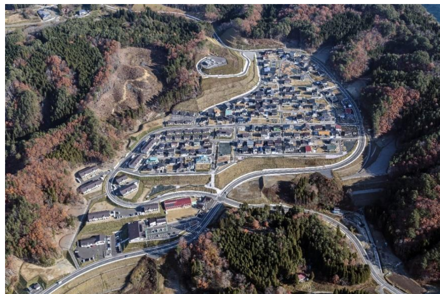
田老三王団地(田老地区防災集団移転促進事業)
