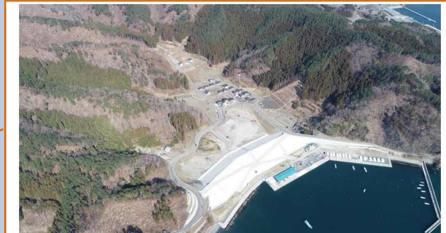
室浜漁港海岸 防潮堤
