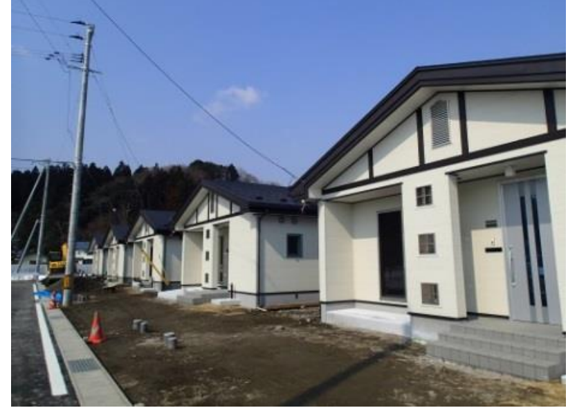
災害公営住宅 久慈湊・大崎地区
