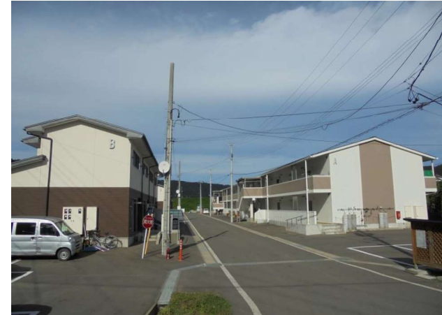
町営住宅小本団地(災害公営住宅整備事業)
