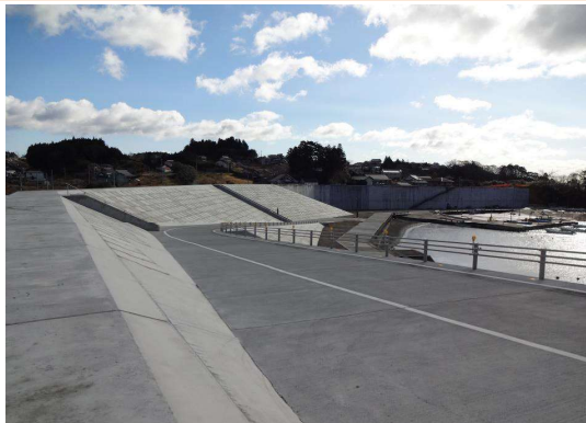
泊里漁港海岸 防波堤
