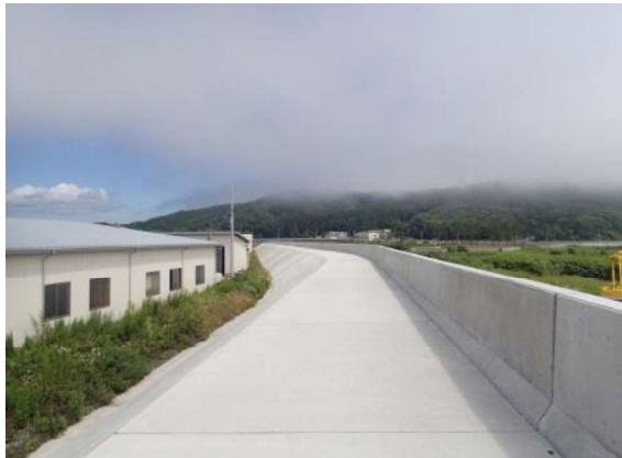
漁港海岸 久慈湊漁港海岸防波堤
