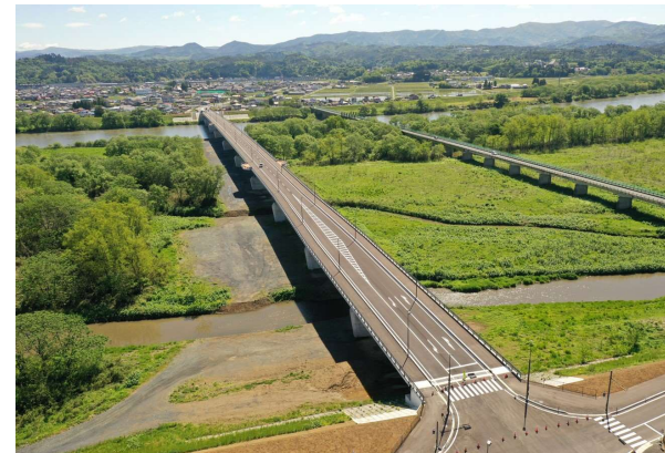
国道397号 小谷木橋 令和3年5月完成
