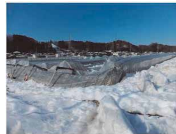
連棟パイプハウスの倒壊
