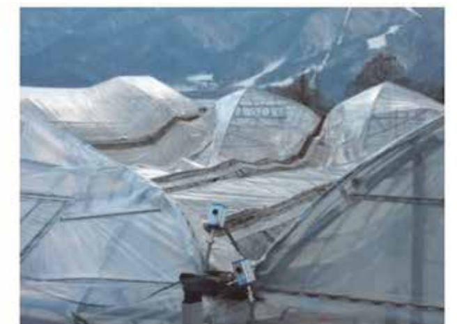
連棟パイプハウスの倒壊
