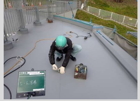
みずの広場の再生工事の様子
