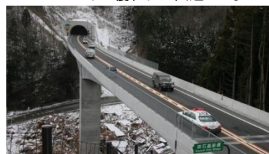
▲「命の道」として機能した釜石山田道路
