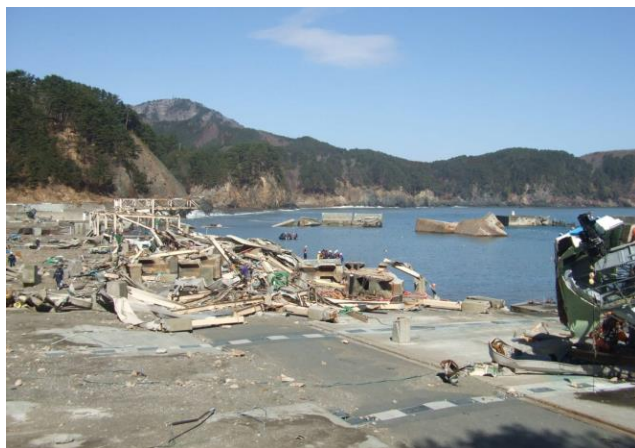
▲宮古市 音部漁港 平成 23 年震災直後
