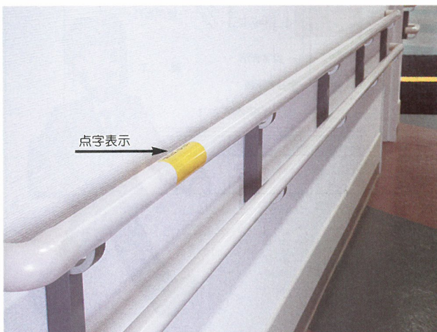
連続した手すりを2段設置
