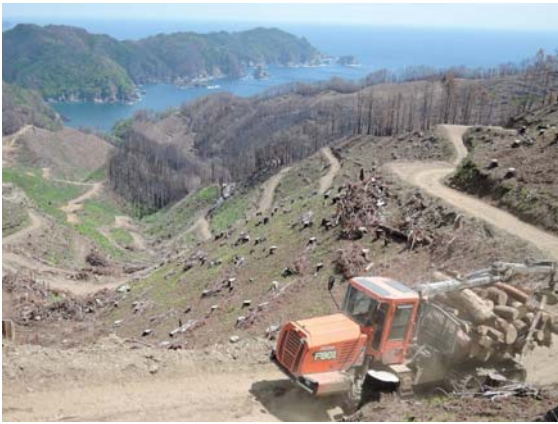
復旧作業の状況（H30.5 現在）
