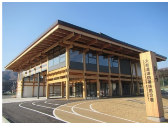
地域材利用施設（大船渡消防署住田分署（H30.3完成））
