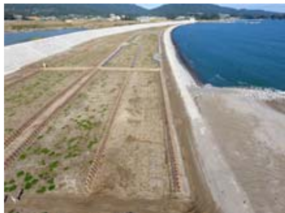
高田松原の復旧状況（H30.3 現在）
