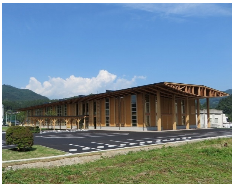
木造2階建ての役場庁舎（住田町）
