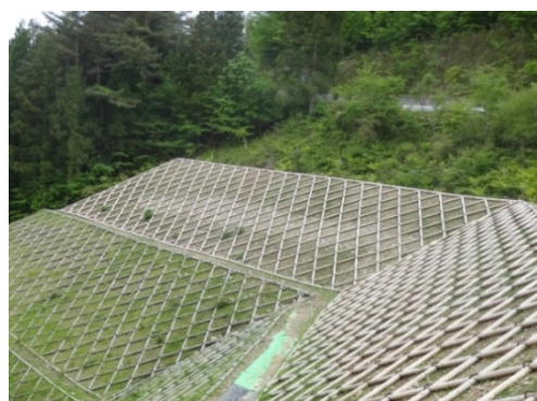
林道工事における法面保護工 （木製法枠工）
