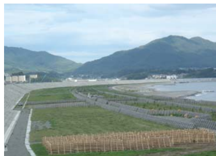
高田松原の復旧状況
