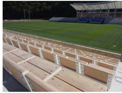
釜石鶉住居復興スタジアム への被害材の活用
