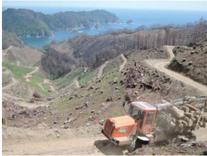
復旧作業の状況
