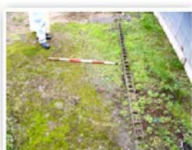
(2)被害状況確認(宅盤) 宅地に亀裂がないか等調査し、宅地全体の被害状況を把握していきます。
