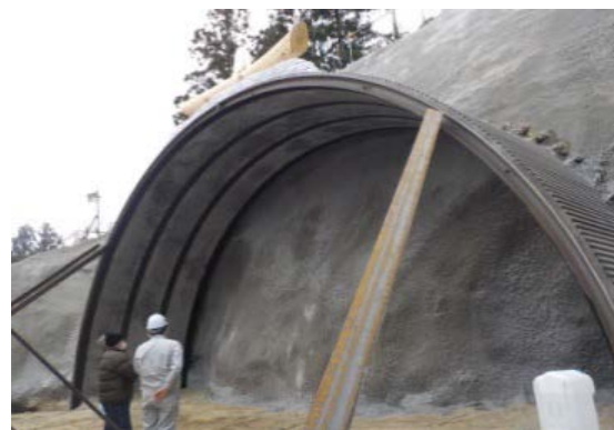
トンネル西側坑口部
