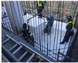
現場微調整(切断)
