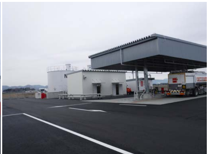
<給油車両積卸場（手前）と給油ポンプ室（中央）>
