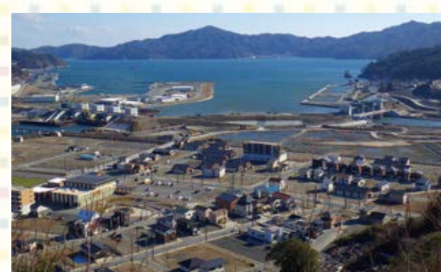
津波から市街地を守る、大槌川水門(左奥)と小槌川水門(右奥)。
