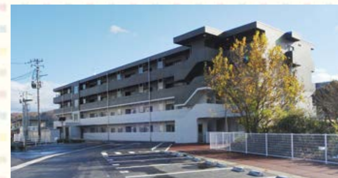
1月に完成した北上市の県営黒沢尻アパート。
