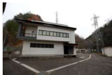
岩洞第二発電所建屋
