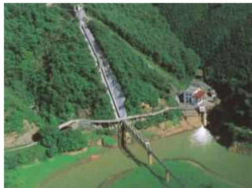
岩洞第二発電所
