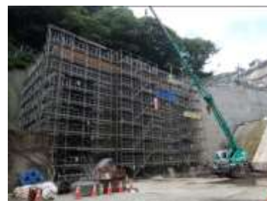
建設中の築川発電所
