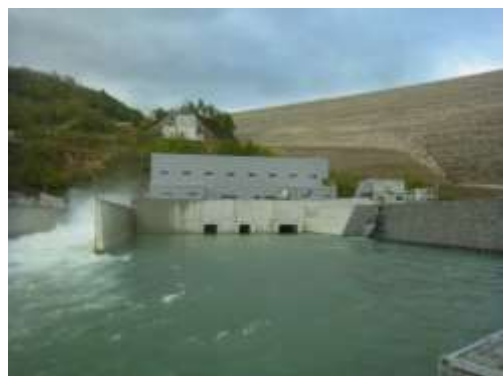
胆沢第三発電所
