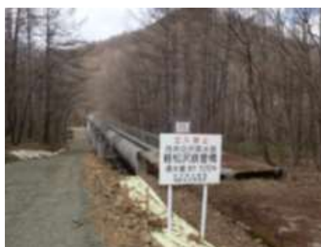
軽松沢鉄管橋
