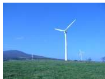
稲庭高原風力発電所（既設）
