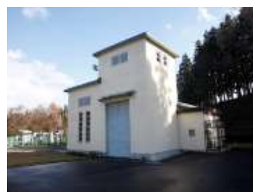
胆沢第二発電所
