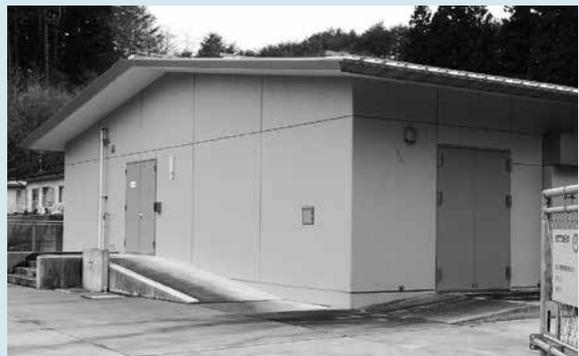
津波対策に高台にて移設した通信ビル
