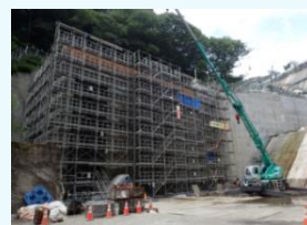
建設中の築川発電所
