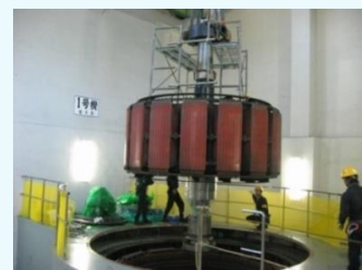
仙人発電所のオーバーホールの様子
