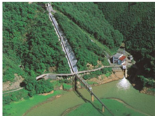
岩洞第二発電所
