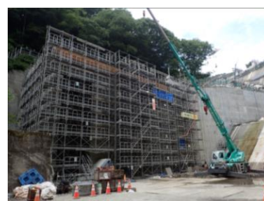
建設中の築川発電所
