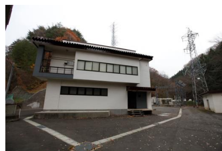
岩洞第二発電所建屋
