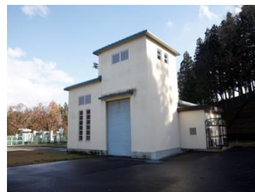
胆沢第二発電所
