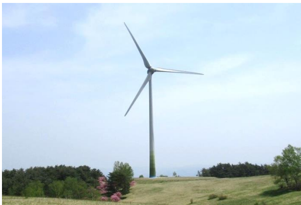
高森高原風力発電所
