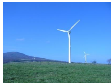
稲庭高原風力発電所
