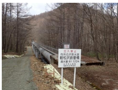
軽松沢鉄管橋
