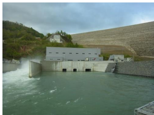
胆沢第三発電所
