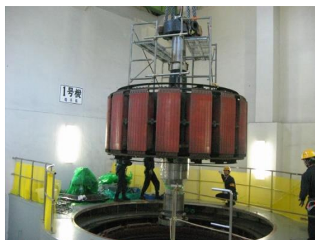
仙人発電所のオーバーホールの様子
