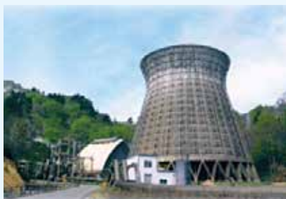
松川地熱発電所
