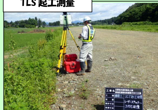
TLS 起工測量
