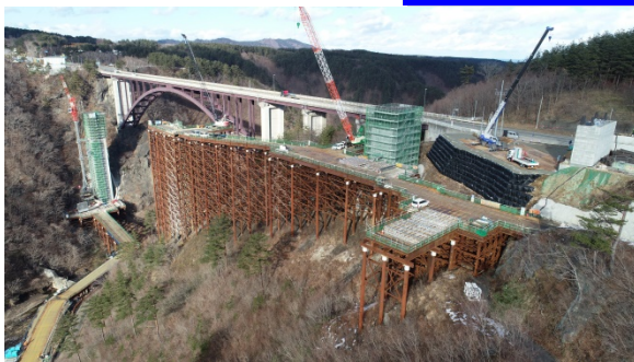
▲三陸沿岸道路 田野畑道路 令和2年度末開通予定 【新思惟大橋（仮）施工状況】 （写真提供：三陸国道事務所）
